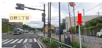
「日野二丁目」の信号を過ぎると右側に看板と工事中の建物が見えます
